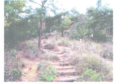
階段損傷部(整備前)
