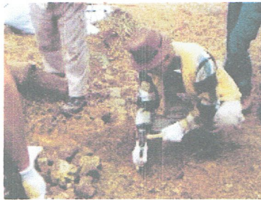
階段の固定、岩部分に留意して打ち込み
